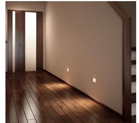
廊下の足元灯 / Step Light
